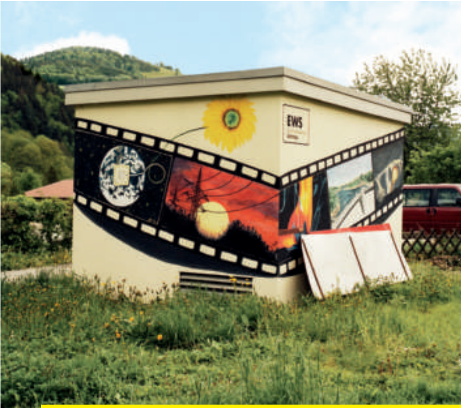
Stromverteilerkasten der EWS, Windrad in Schönau.
