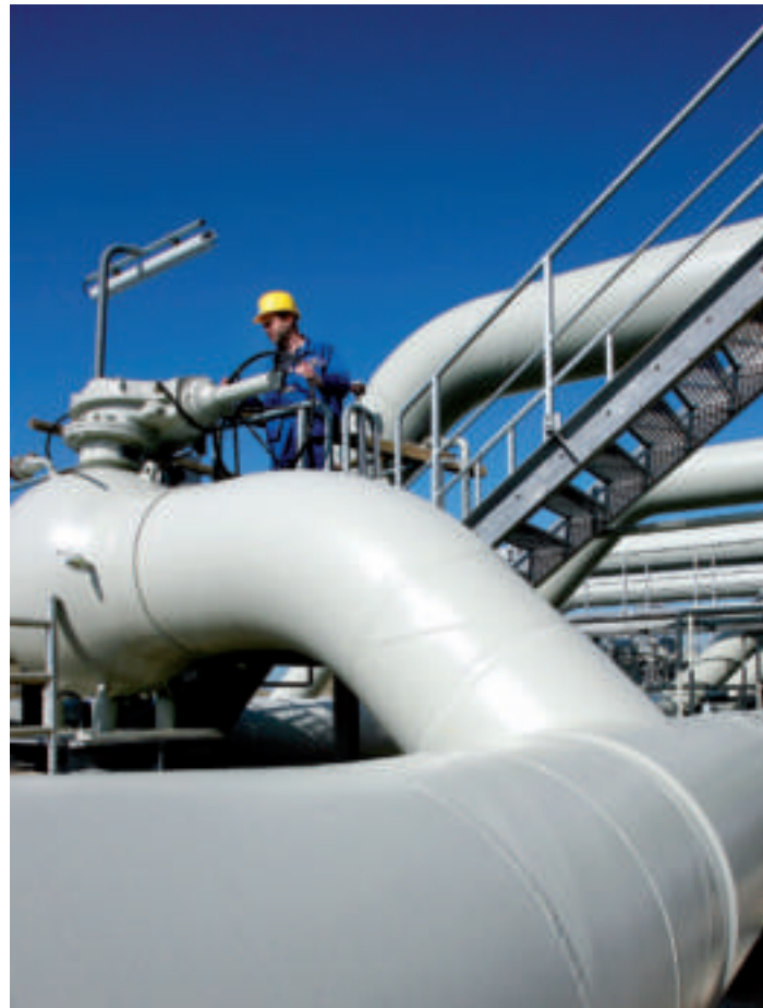
Verdichtungsstation des deutsch-russischen Erdgasversorgers Wingas in Eischleben bei Erfurt.
