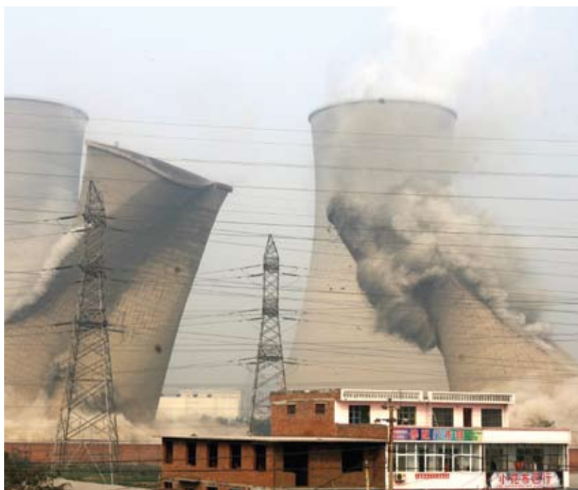
Es bewegt sich was: Als Zeichen des guten Willens lässt China zwei Kühltürme eines Kohlekraftwerks in Xinxiang einreißen
